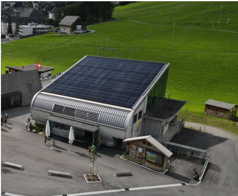
Foto: Neue 60kWh Solaranlage auf der Talstation der Luftseilbahn. [Copyright: Brunni-Bahnen Engelberg AG]
